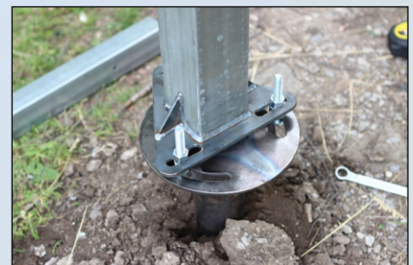
Стойка ограждения на винтовой свае
